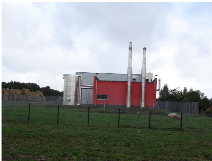
Fot. 5 Kotłownia na biomasę w Daszynie.
